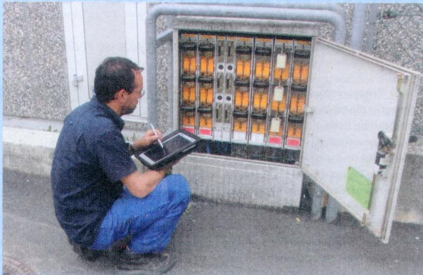
Die GeoApp kommt in Brixen in der Netzfürung zum Einsatz. Es stellt Lageinformationen als auch Schalt- und Sicherungszustände mobil zur Verfügung.
